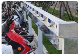
非机动车辆充电桩安装
